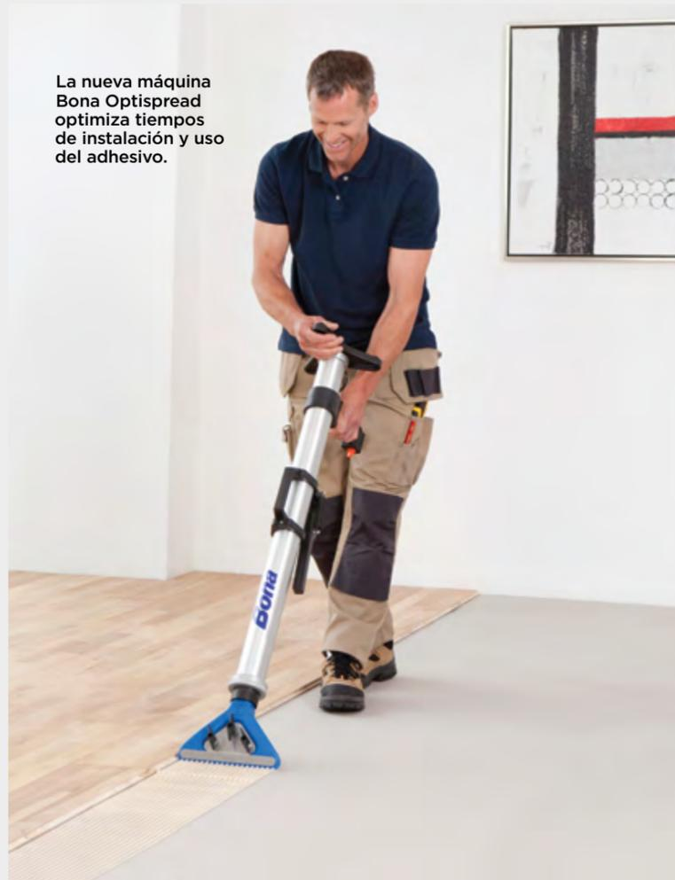
La nueva máquina Bona Optispread optimiza tiempos de instalación y uso del adhesivo.
