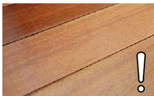
Un clima muy seco, al igual que la temperatura elevada de la calefacción, ocasionará la contracción del piso generando luces entre las tablas.
